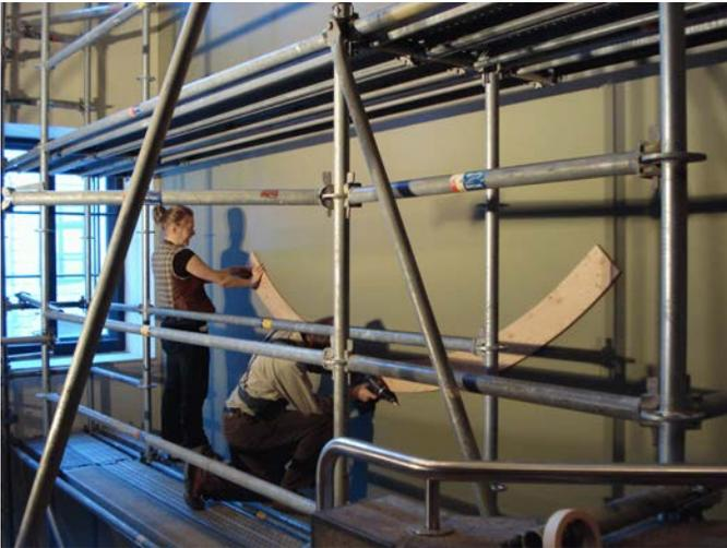
Figure 18. Installation des contre-plaqués. © CCQ.
