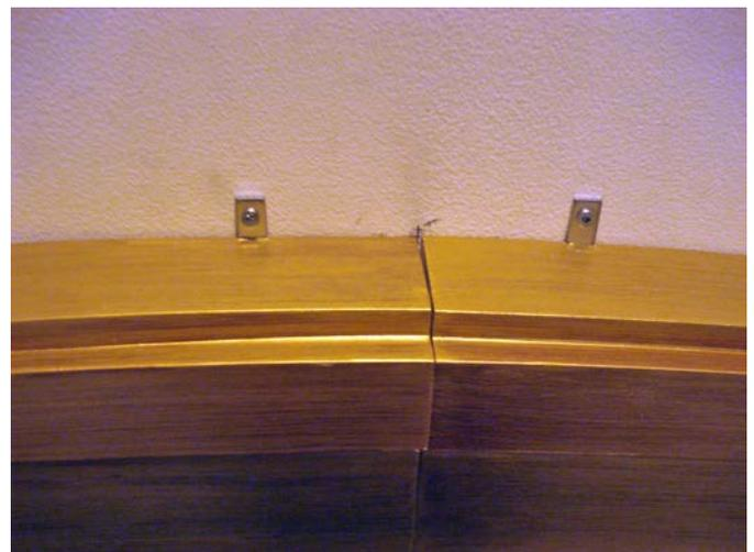
Figure 22. Équerres sur les éléments du haut. © CCQ.
