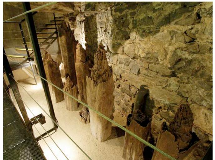
**Figure 6.** À gauche, le support d'un pilot lors de son installation et à droite, les pilots de bois installés au Musée, après recouvrement des supports à l'aide d'un sol de remplissage et la mise en lumière. Photo : Alain Vandal, Pointe-à-Callière.
